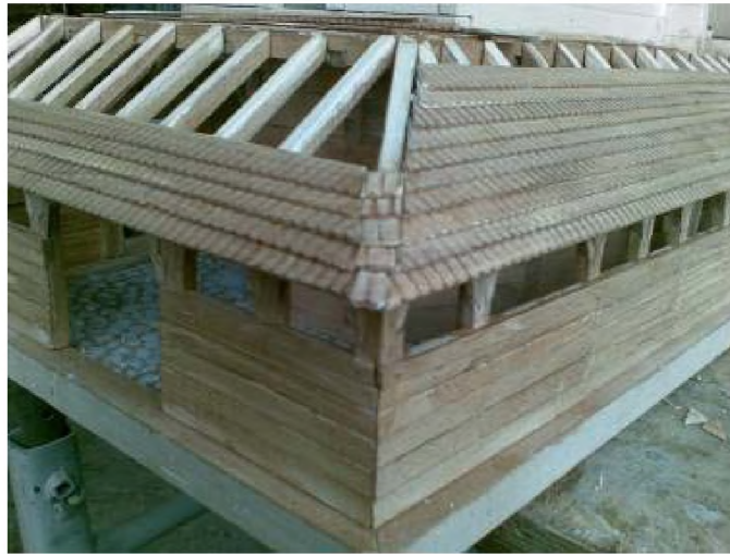
Рис. 4. Покриття даху і піддашся «гонтами»
