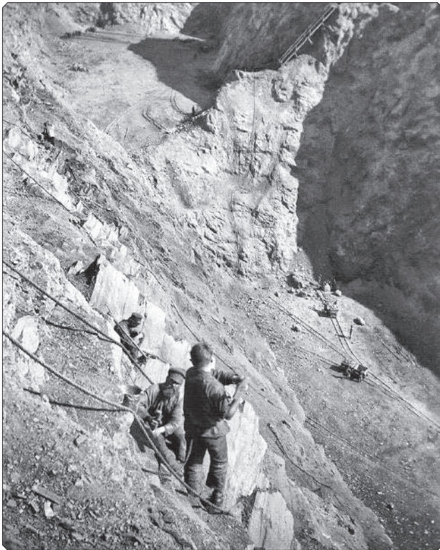
Ілюстрація № 1. Ручне буріння на схилі кар'єру. Рудник «Дубова Балка». Фото Е. Фукса. Поч. ХХ ст.
