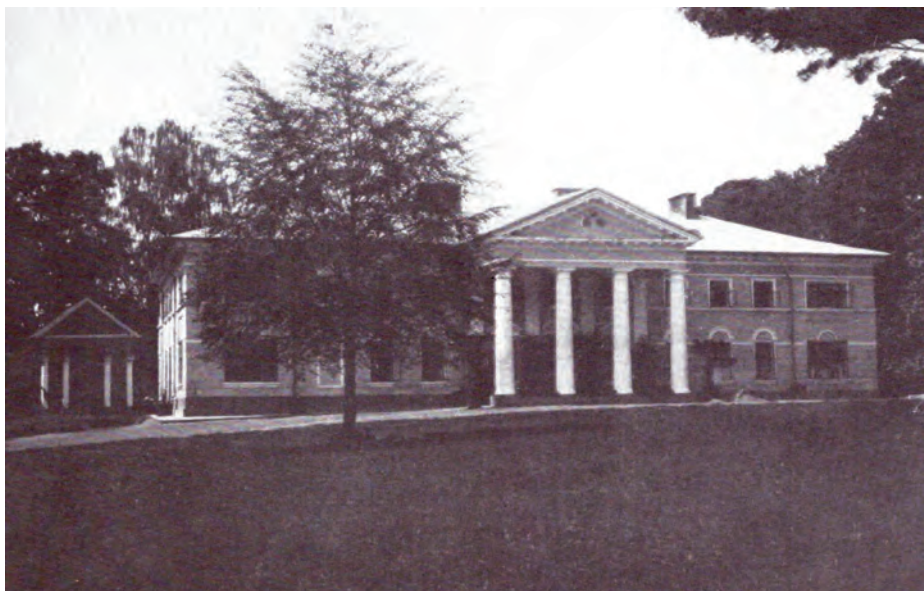
Nr 3.5. Elewacja frontowa pałacu hrabiów Bielskich w Rychny po rekonstrukcji w latach 20. i 30. XX w. z altaną po prawej stronie. Zdjęcie podróżnika Romana Aftanazego, 1937 r.
