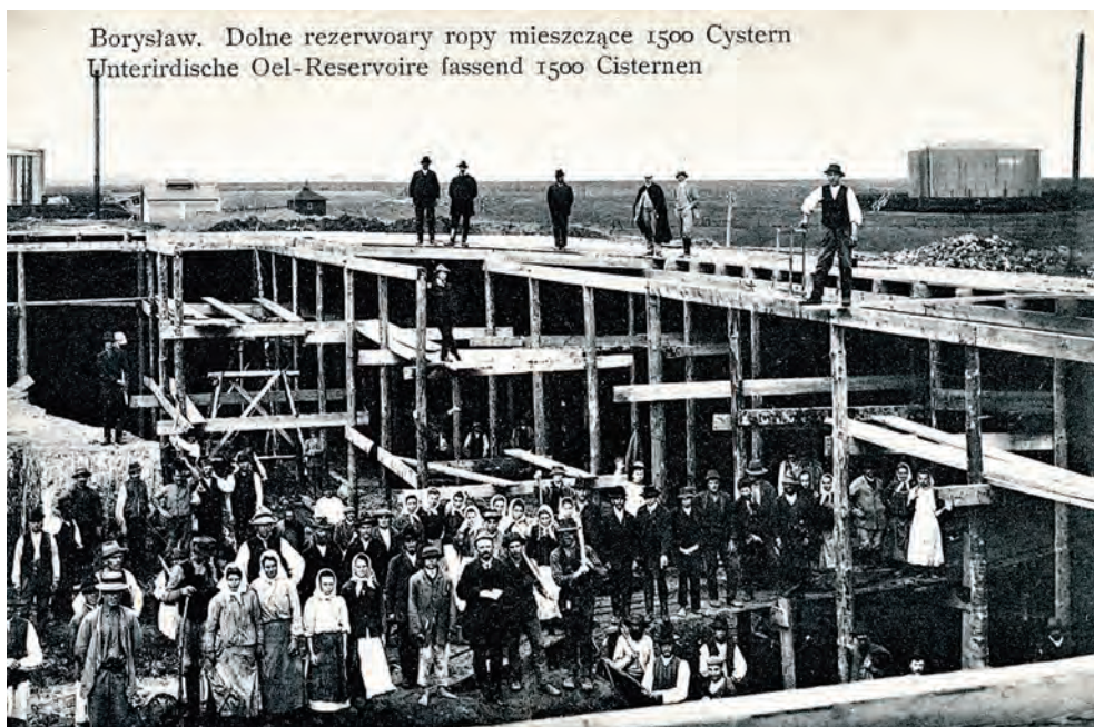
Nr 2.211. Prace końcowe przy budowie jednego z ziemnych zbiorników ropy naftowej w Borysławiu-Tustanowiczach. Pocztówka z 1909 r. z wydawnictwa J. Piłpla w Drohobyczu
