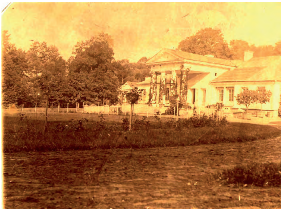
Nr 3.1. Zabytkowy pałac hrabiego Juliusza Roberta Bielskiego w Rychtyczach z klatką schodową w stylu empire na długo przed gruntowną przebudową w latach 20. i 30. XX w. Fotografia z 1897 r. wykonana podczas podróży burmistrza Drohobycza Ksenofonta Ochrymowicza z żoną Wilhelminą Marią von Emerling i trzyletnim synem Stanisławem do majątku rychtyckiego rodziny Bielskich (dziś zdjęcie przechowywane jest w archiwum rodzinnym prawnuka K. Ochrymowicza – Tomasza Osterloff’a)
