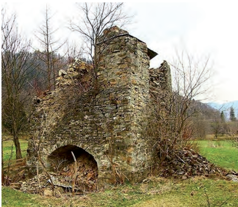
Nr 1.61. Ruiny wielkiego pieca zbudowanego w 1814 r. do wytopu rudy żelaza z niemieckiej kolonii Maimanstahl we wsi Majdan. Zdjęcie 2011 r.
