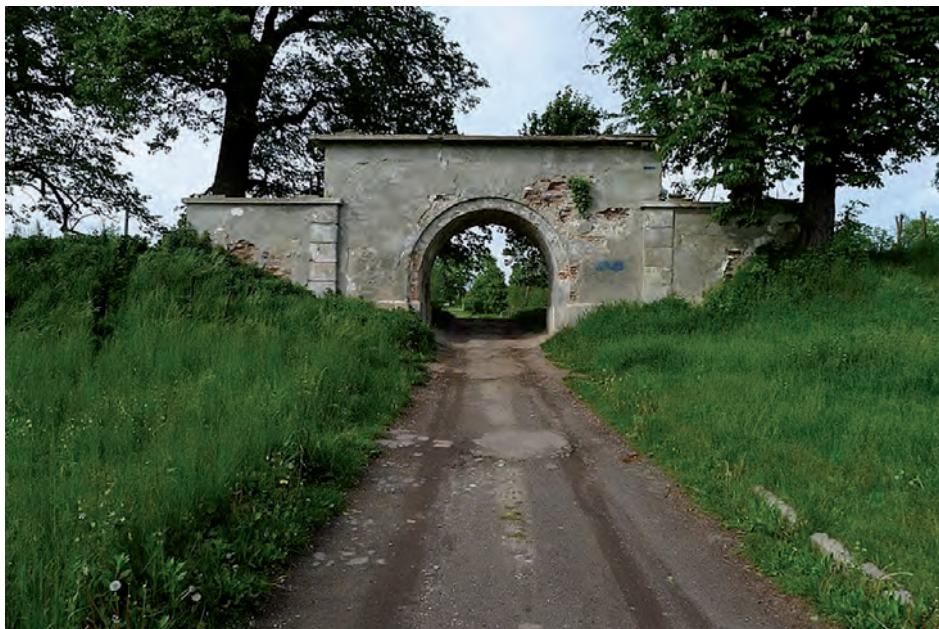
Nr 3.11. Nowa brama wjazdowa z 1880 roku. Widok z dziedzińca pałacu hrabiów Bielskich w Rychtyczach. Zdjęcie 2019 r.
