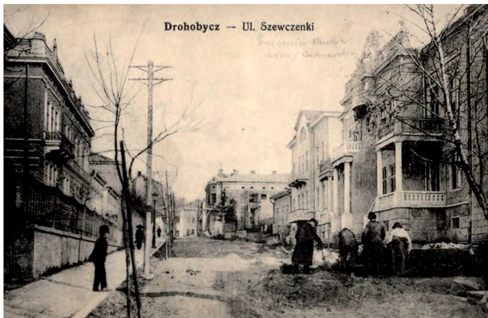
№ 2.161. Remont węzła kanalizacji na ulicy. T. Szewczeni. Pocztówka z ostatniej tercji XIX w.
