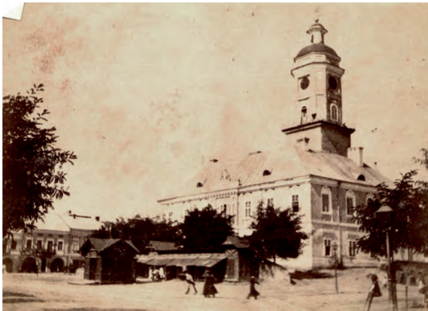
Nr 2.93. Stary ratusz Drohobycza przed rozpoczęciem pierwszych prac remontowych. Pol. lat 90. XIX w., archiwum Ochrymowiczów i ich prawnuka Tomasza Osterloff'a
